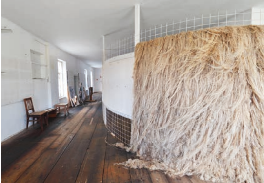
Der Zustand der Textilfabrik zum Zeitpunkt der Übernahme durch die Initiative
