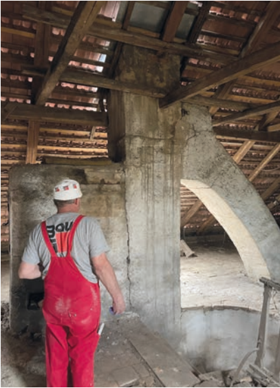
Begutachtung der Bausubstanz als wichtige Phase der Objekt(an)eignung
