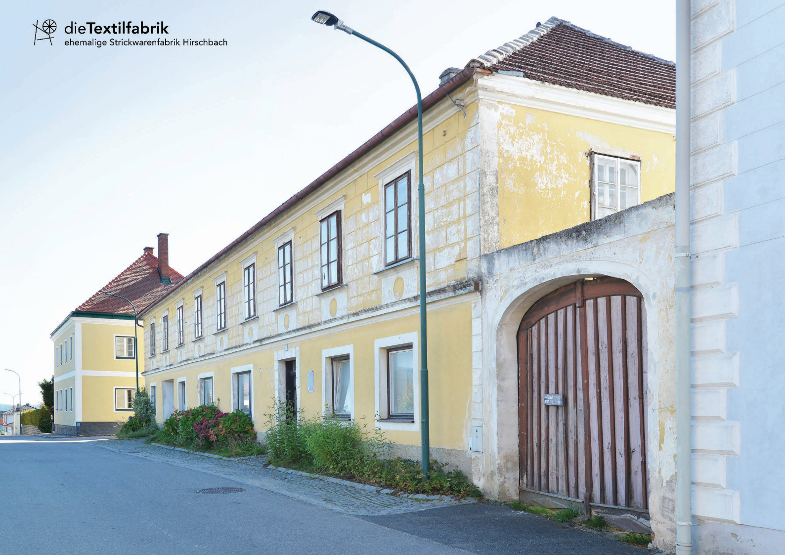
Die ehemalige Textilfabrik, Frontfassade an der Vitiser Straße mit Einfahrtstor zum Innenhof
